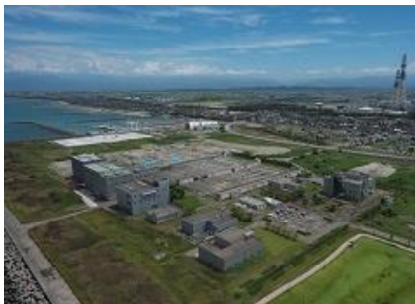
神通川左岸浄化センター
