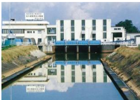
東部排水機場
