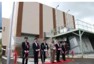
海老江排水機場
