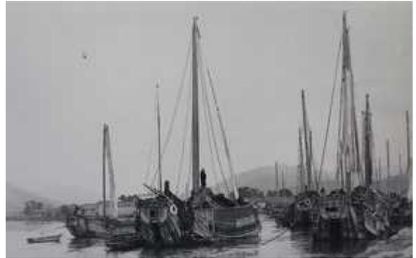
櫓と帆を併用し、500石積では11~13人、千石積では12~22人、1500石積では27・8人の水主が必要であった。一般に1000石積以上の大型船は北国船、800石積以下の中・小型船は「ハガセ船」であり、北国船は数を減らすが、「ハガセ船」は幕藩末頃まで用いられた。
